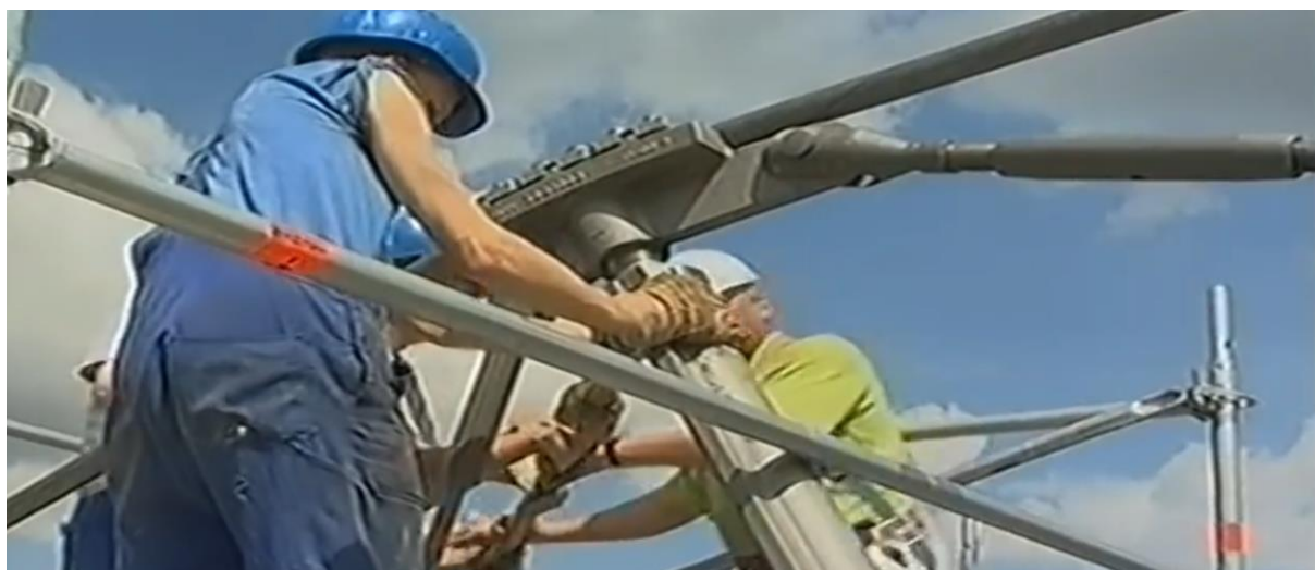
Rysunek 38 Odbывająca się czynność regulacji napięcia cięgna za pomocą wydłużenia dewiatora
