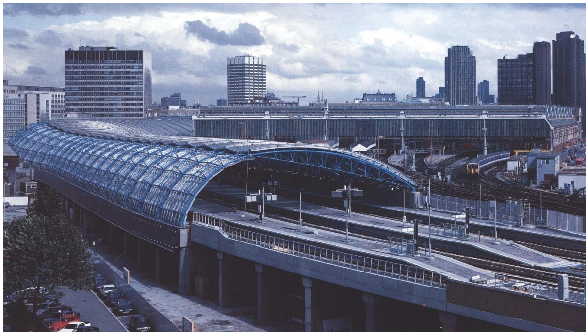
Rysunek 13 Widok na przekrycie Terminala Waterloo w Londynie.
