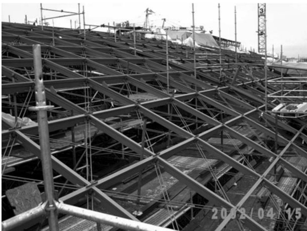
Rysunek 78 Referencyjne zdjęcie rzeczywistej siatki stalowej pod pokrycie szklane [11]
