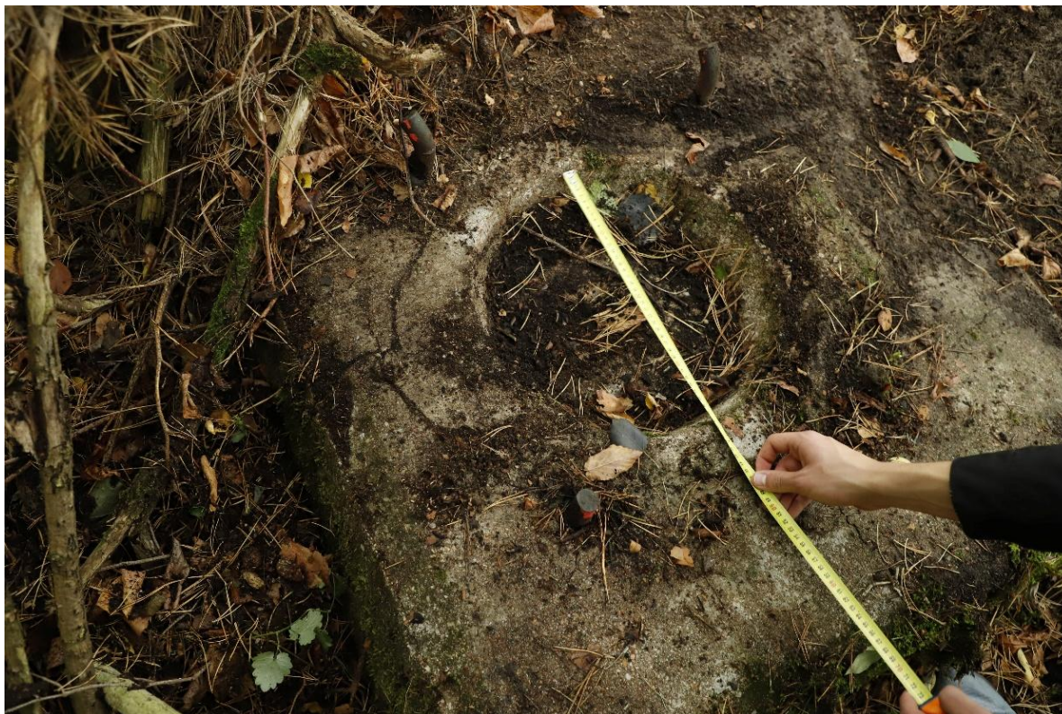
Rys. 3.5. Przykład zachowanego fundamentu zewnętrznego hangaru, całkowicie zagłębionego. Źródło: Fotografia własna
