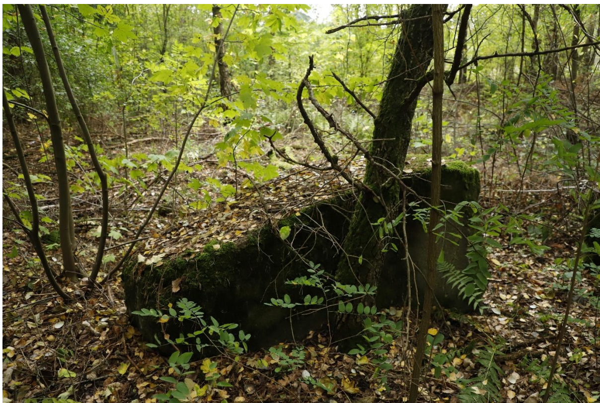
Rys. 3.6. Przykład zachowanego odsłoniętego, zewnętrznego fundamentu hangaru. Źródło: Fotografia własna
