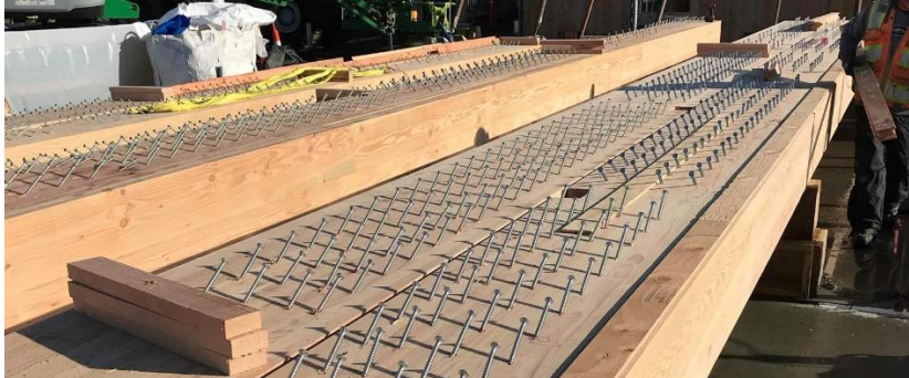
Imagen 04: Forjado de CLT con conectores tipo clavija
